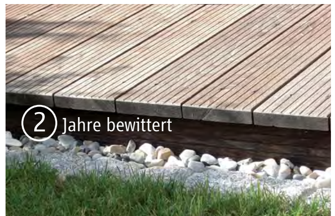
TMT-TerrassenProfil H-GROOVE 25 x 130 mm TMTEsche unbehandelt sichtbar befestigt Einfamilienhaus Neu-Ulm, Bayern
