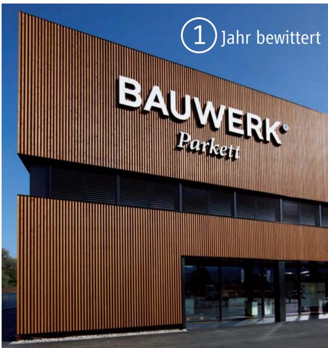
TMT-FassadenProfil INDIVIDUAL 80 x 50 mm in TMTFichte geölt
