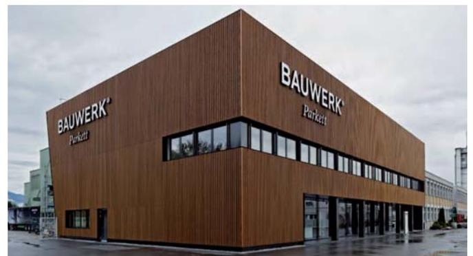
Fasadengestaltungen in Stäben sind Trend. In diesem Fall wurde vom Architekten eine Dimension von 80 x 50 mm in einer Länge von bis zu 5,0 m gefordert. Die Stäbe wurden entsprechend aus bis zu vier Lamellen mit Polyuretan wasser- und wetterfest verleimt. Die äußere Lamel-
