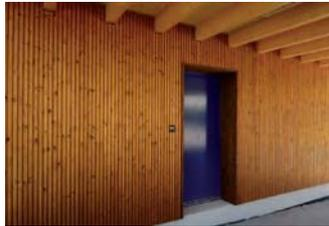
TMT-Fassadenprofil S-TMT 27 x 90 mm in TMTFichte geölt
