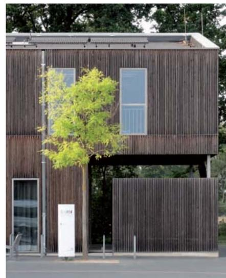
Nun beweist dieses Projekt seit über einem Jahrzehnt, dass TMT extrem formstabil und dauerhaft ist. Jedes Jahr überprüfen wir den Alterungsprozess, die Formstabilität und die Beständigkeit.
