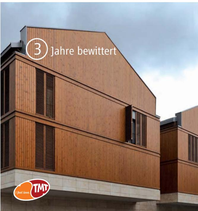
TMT-Fassadenprofil S-BETA 21 x 116 mm in TMTKiefer lasiert
